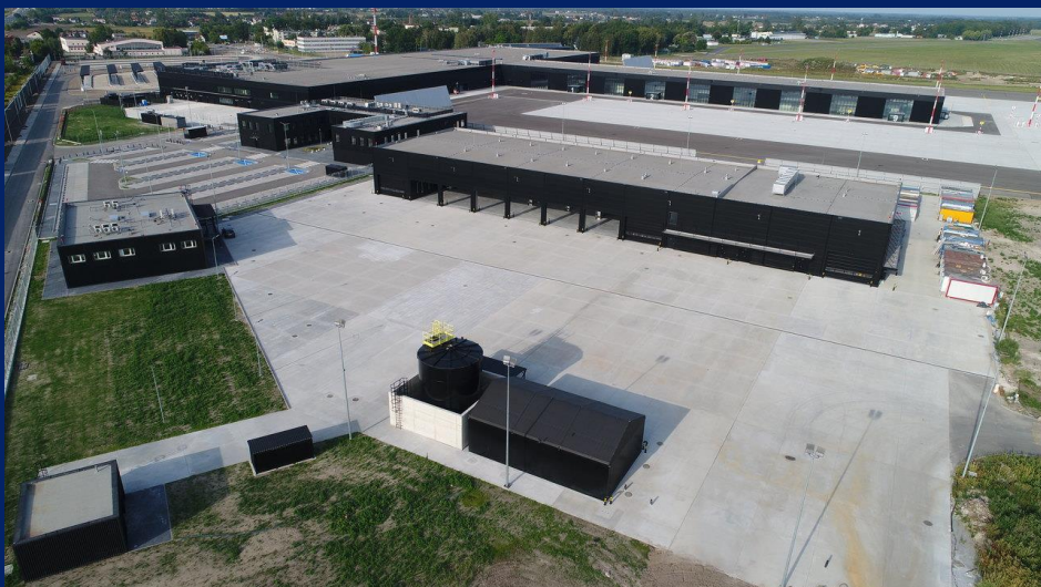
Hala garażowa, budynki służb
